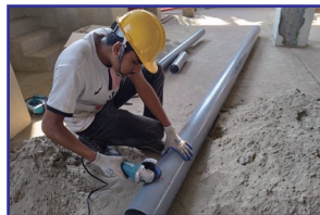
屋内外配管実技訓練
