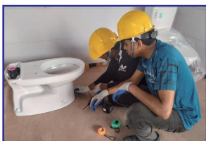
衛生器具取付訓練
